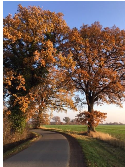
Abb.: Straße Gemeinde Manhagen (ohne ausgebauten Radweg)
